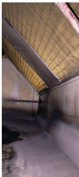
Zdj. 1 Stan lamel wymiennika ciepła.
