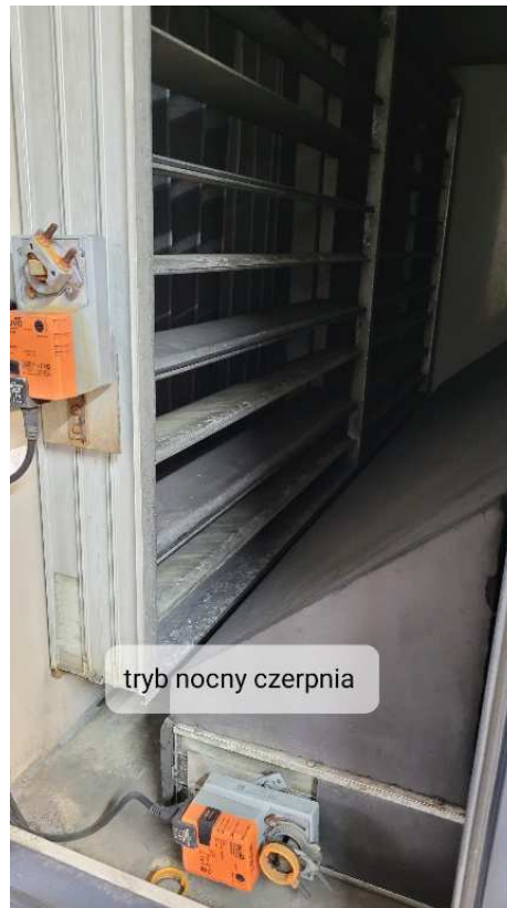
Zdj. 3 Otwarta przepustnica czerpni w nocnym trybie pracy basenowej centrali wentylacyjnej.
