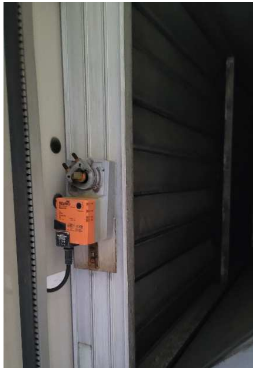
Zdj. 2 Zamknięta przepustnica czerpni w dziennym trybie pracy basenowej centrali wentylacyjnej.
