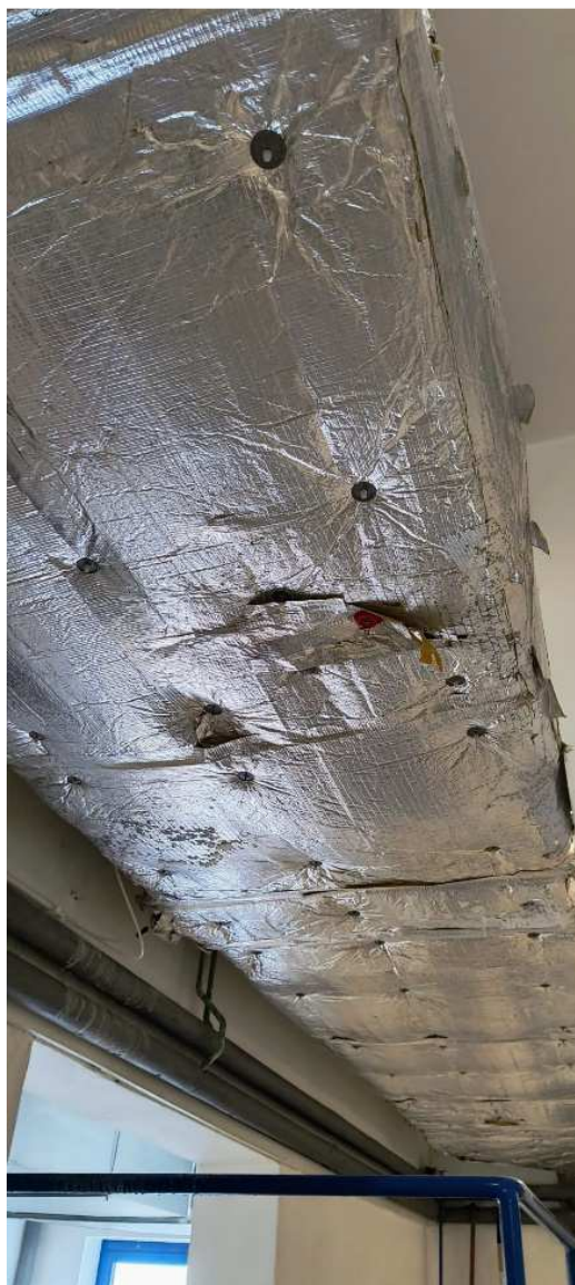
Zdj. 25 Stan izolacji na kanałach nawiewnych prowadzonych w podbaseniu
