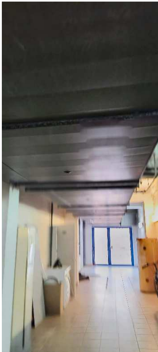
Zdj. 23 Brak izolacji na kanałach wyrzutowych
