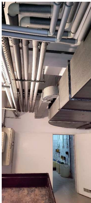
Zdj. 22 Brak izolacji na kanałach wywiewnych
