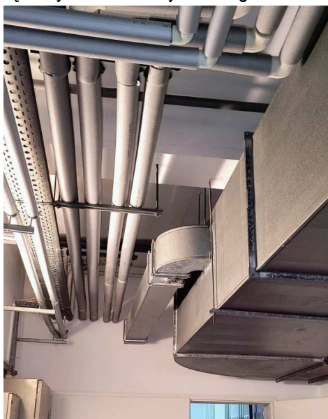
Zdj. 9 Wywiew powietrza z pomieszczenia filtrowni
