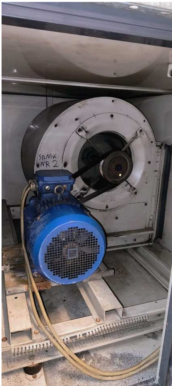
Zdj. 5 Wentylator z przekładnią pasową znajdujący się w basenowej centrali wentylacyjnej.
