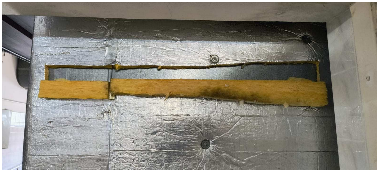
Zdj. 24 Izolacja na kanale nawiewnym
