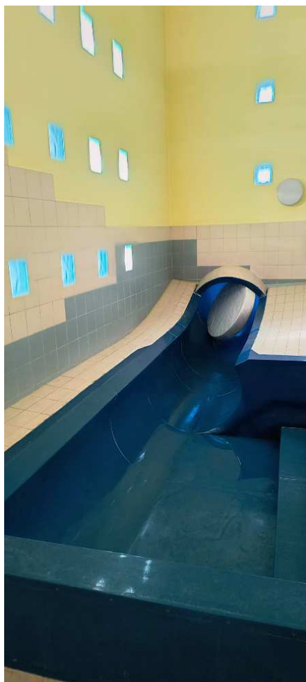
Zdj. 18 Przesłona przepływu powietrza w zjeżdżalni wodnej
