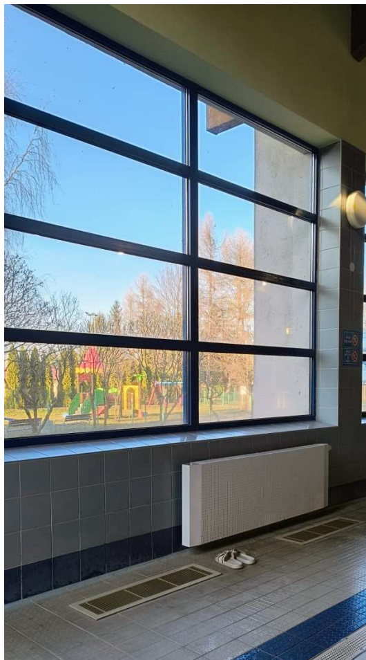
Zdj. 12 Zbyt nisko zamontowane nawiewniki szczelinowe zabezpieczające okna przed wykropleniem
