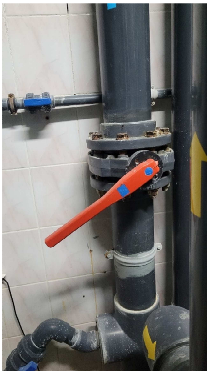
Zdj. 29 Skrzyżowany zawór w instalacji basenowej
