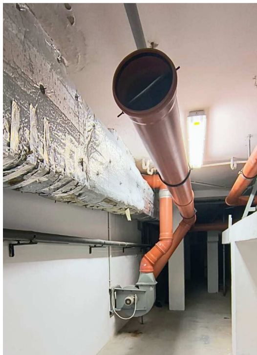
Zdj. 8 Element wywiewny z pomieszczenia podbasenia
