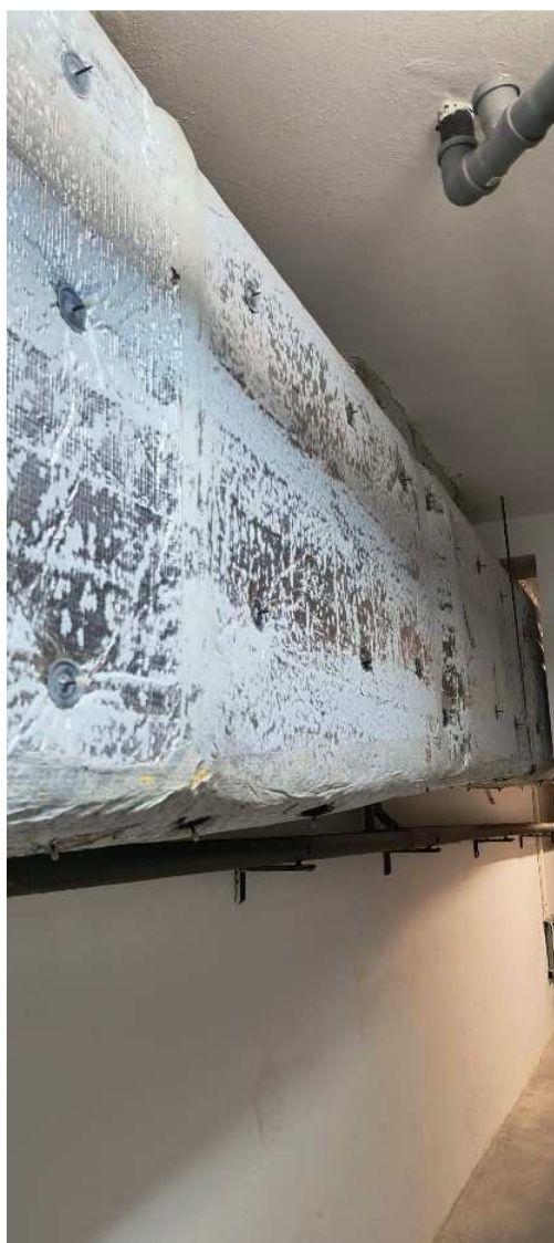
Zdj. 27 Degradacja materiałowa izolacji cieplnej
