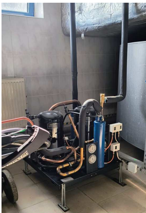
Zdj. 7 Pompa ciepła zamontowana w centrali basenowej
