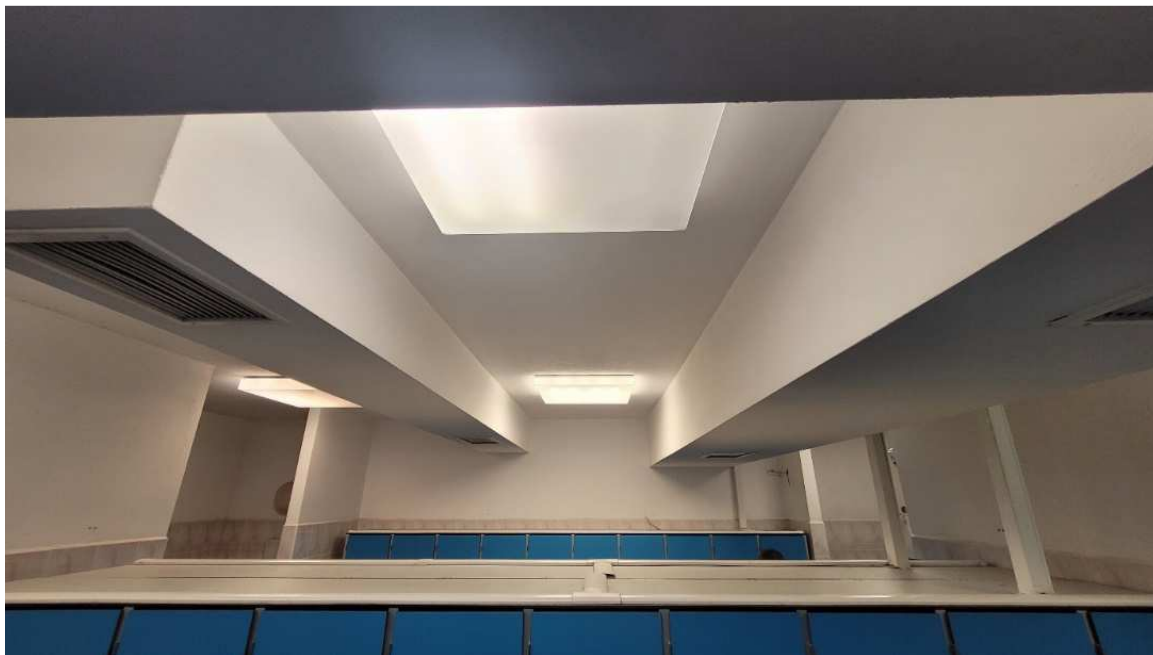
Zdj. 19 Elementy dystrybucyjne powietrza w przestrzeni szatniowej
