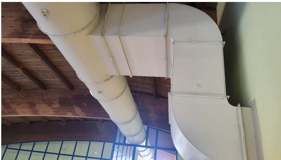
Zdj. 14 Kanał wywiewny obsługujący halę basenową oraz część ogólną
