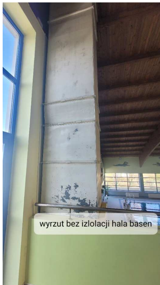
Zdj. 15 Kanał wyrzutowy bez izolacji prowadzony na hali basenowej
