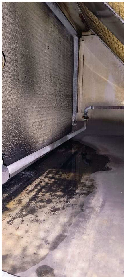
Zdj. 6 Skraplacz-parowacz w basenowej centrali wentylacyjnej.
