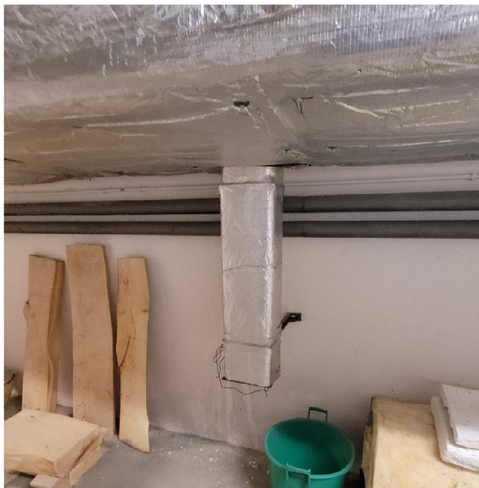
Zdj. 7 Element nawiewny w pomieszczeniu podpasienia
