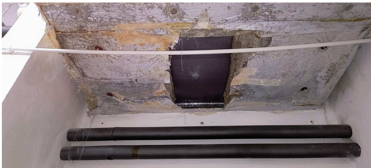
Zdj. 26 Uszkodzenia mechaniczne izolacji cieplnej
