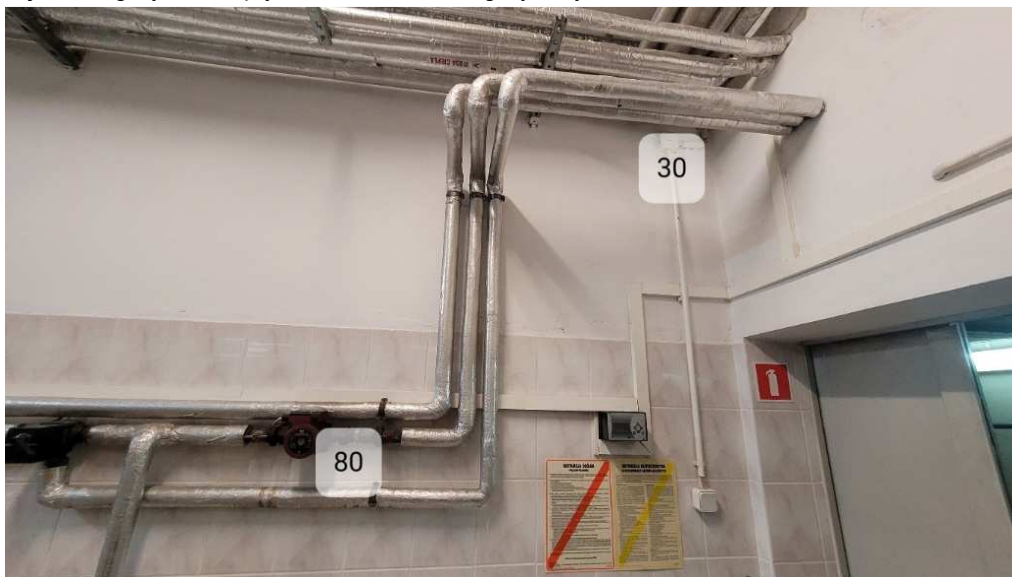
Zdj. 30 Pompa obiegowa instalacji solarnej pracująca bez przepływu czynnika
